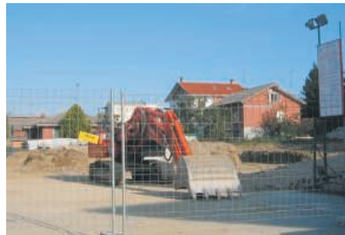
Il cantiere per la costruzione del nuovo edificio
