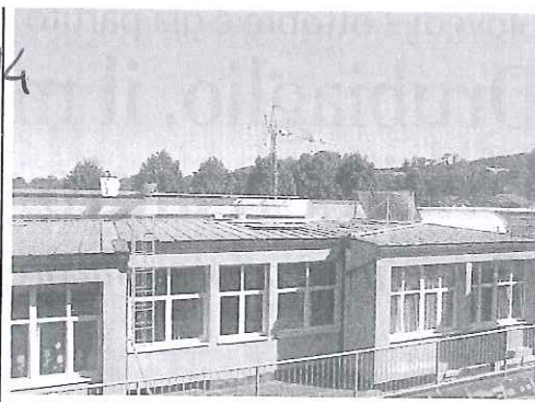
Lavori in corso nelle scuole di Rosta
